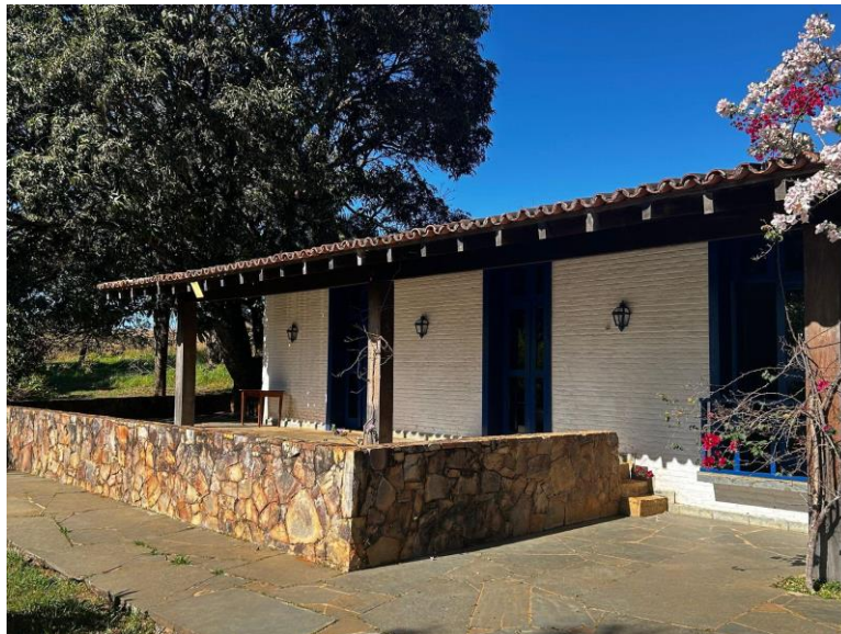
Figura 9: Fachada frontal da Fazenda JK
