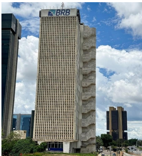
Figura 1: Fotografia do Edifício Brasília em seu estado atual.
