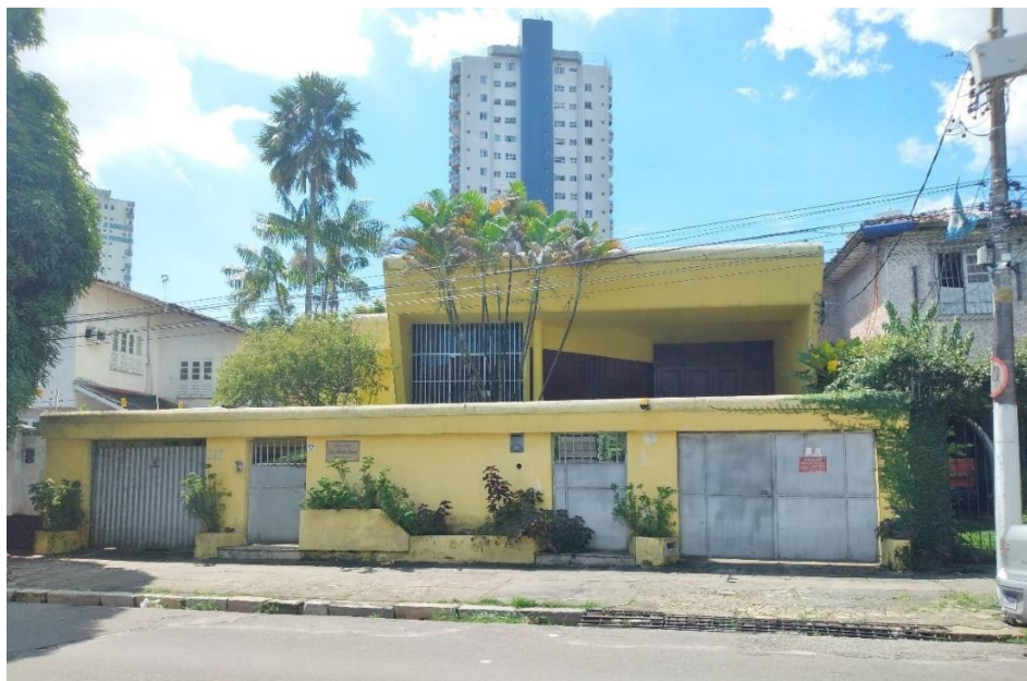
Figura 8 Fachada atual da casa de Camillo Porto.
