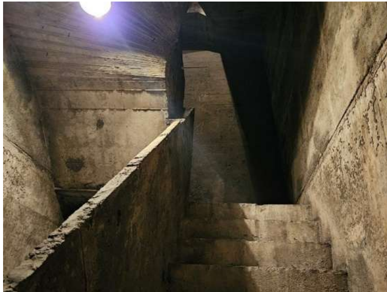
Figura 16: Catedral Metropolitana do Rio de Janeiro. Escada de acesso à cobertura.
