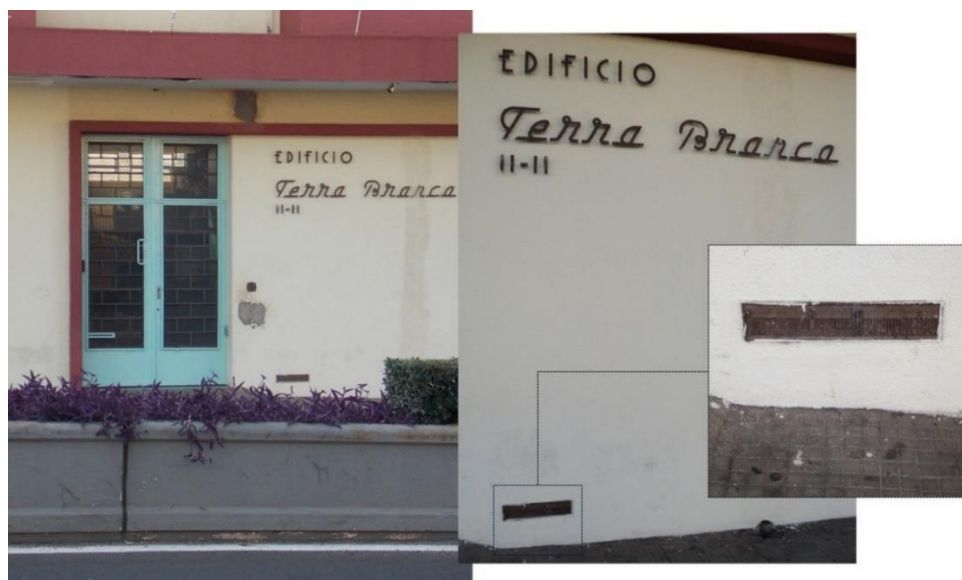
Figura 4: Edifício Terra Branca e registro da placa da construtora, evidenciando a atuação empresarial na produção do edifício.
