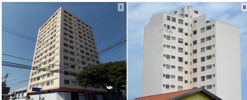
Figura 5: O Edifício Tóquio e suas faces. I, face voltada para o cruzamento da Praça Rodrigues de Abreu. II, faces voltadas ao miolo da quadra.
