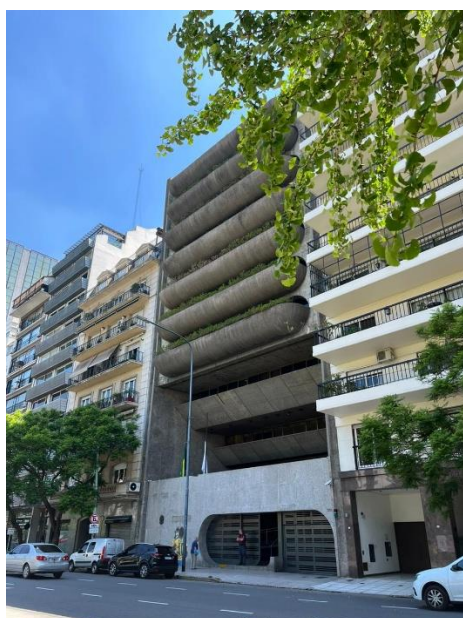
Figura 6: Fachada principal da chancelaria e relação com o entorno.
