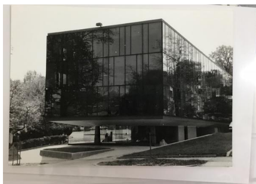
Figura 7: Fotografia do acesso principal ao edifício da Chancelaria, a partir da via da Embassy Row.
