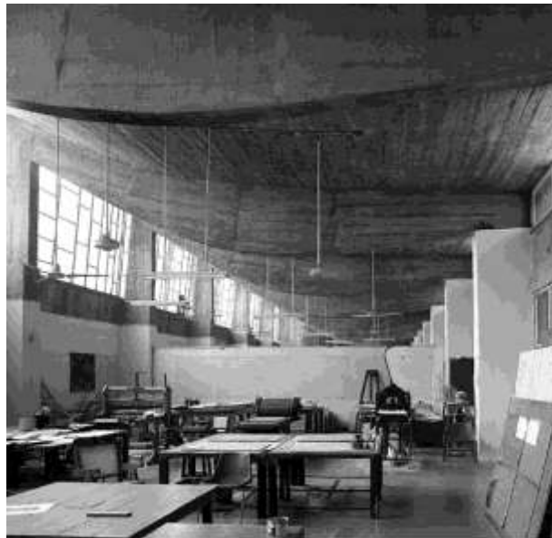
Figura 12: Vista interna da estrutura na Escola de Artes e Arquitetura em Chandigarh.
