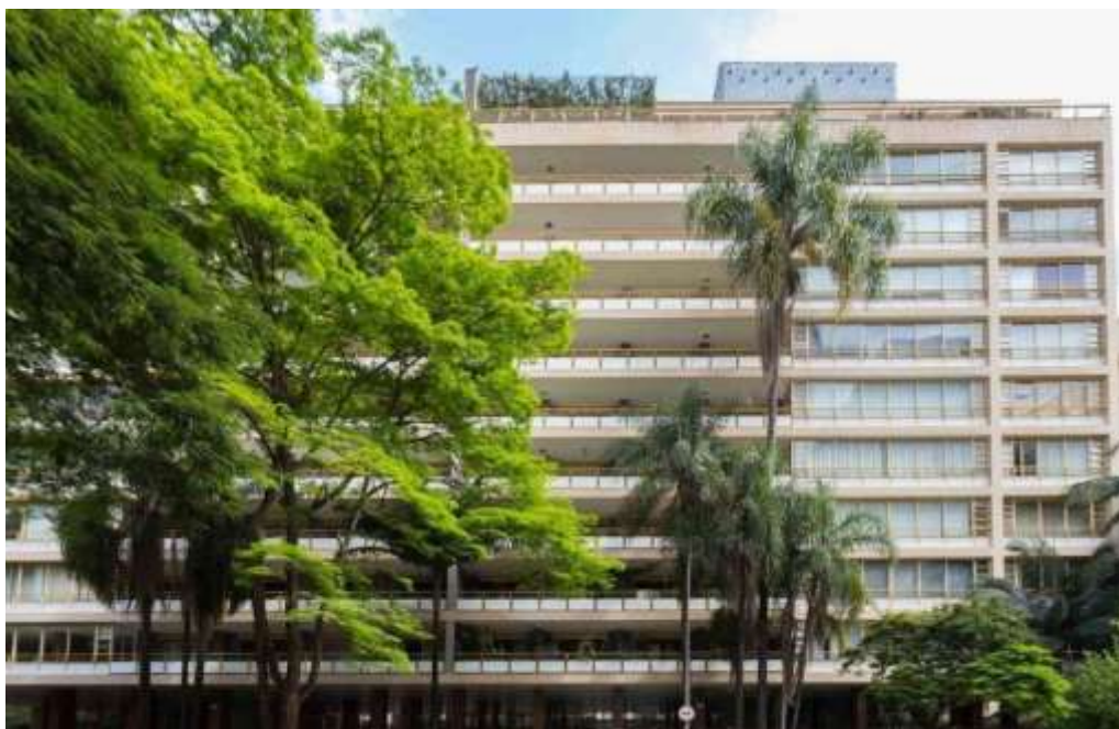
Figura 02 – Fachada do Edifício Prudência
