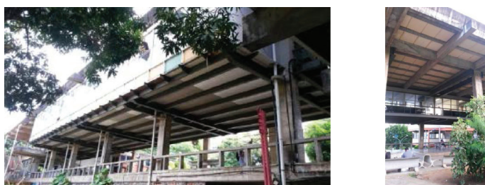
Figura 30 | Vistas do vigamento principal (articulação aço & concreto)
