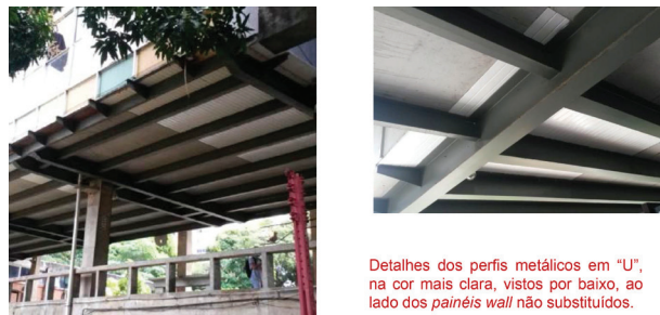
Figura 32 | a) Foto dos perfis metálicos em “U” (ao lado dos painéis); b) Detalhe dos perfis metálicos em “U”, na cor mais clara, vistos por baixo, ao lado dos painéis wall não substituídos. Fonte: Acervo do autor (2018)
